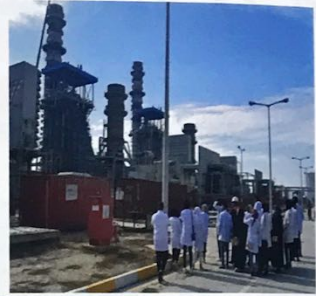
تفتتح الكلية التقنية الهندسية ميسان في محطتها الغازية المحطة الكهربائية الغازية من ميسان لطلبتها لزيارة المحطة لشرح مفصل عن مبادئ توليد الكهرباء وطرق إنتاجها والصيانة التي يجريها خبراء الصيانة فضلاً عن شرح مبادئ التشغيل والتحكم في المحطة.
